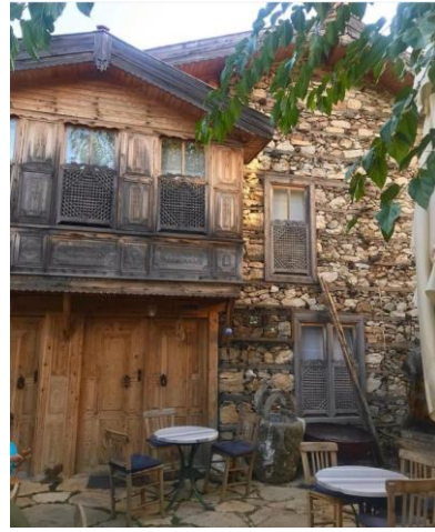
Görsel 2. Kuru Duvar Tekniği ile İnşa Edilen Düğmeli Ev Örneği (Ormana Mahallesi-İbradı, 29. 08.2021)
